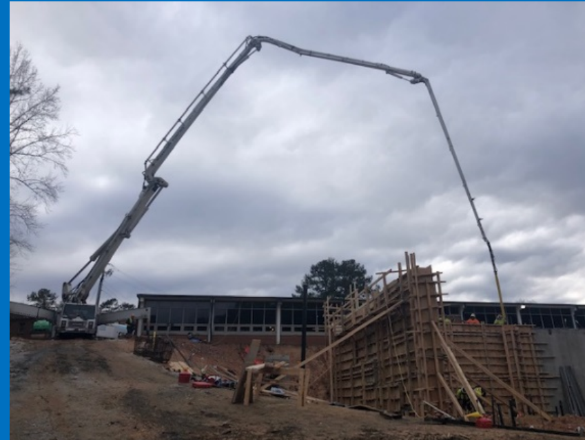
Concrete Wall Pour at Gymnasium
